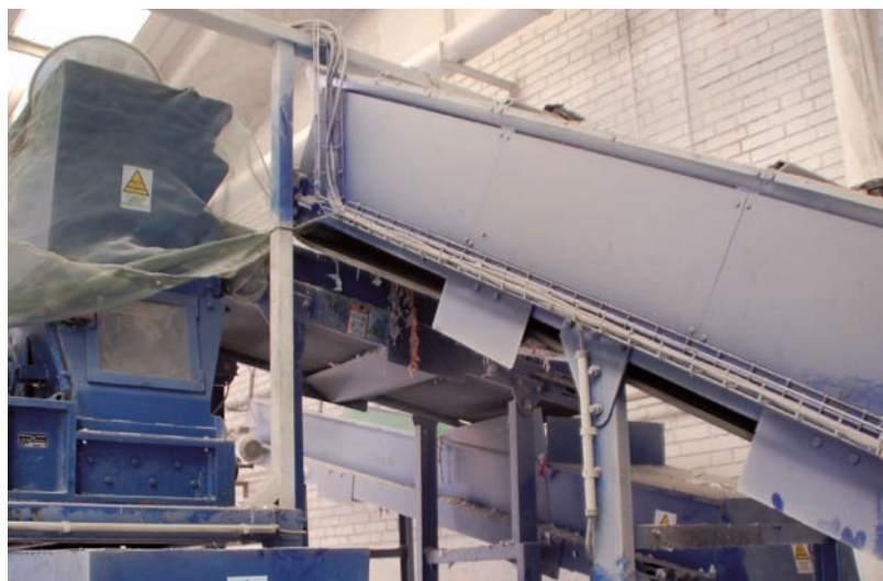
Foto 5: Zona de destrucció confidencial.
